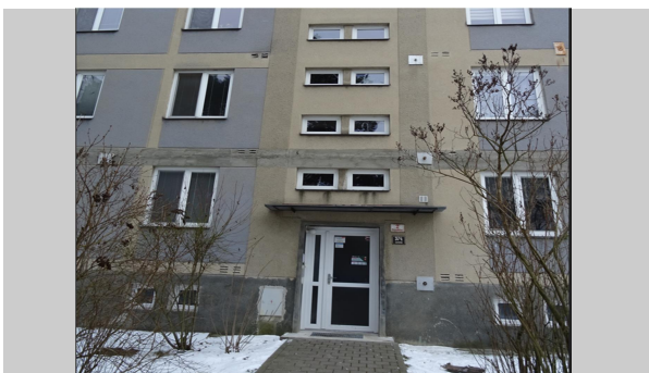
Pohled na vstup do budovy
